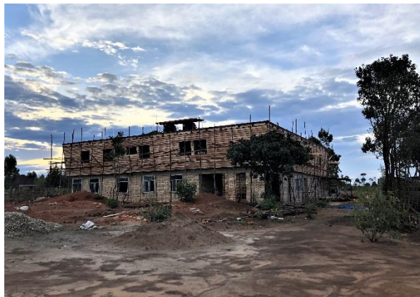
Seminarhaus Mafinga im Bau
