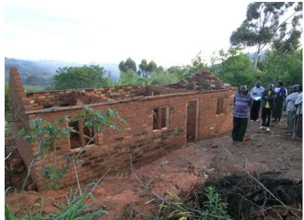
Auf die Stampflehmwände von diesem alten Haus wurden sonnengetrocknete Ziegel auf gemauert und das Dach renoviert. Re Bild Komitee besichtigt Baufortschritt eines Familienhauses
