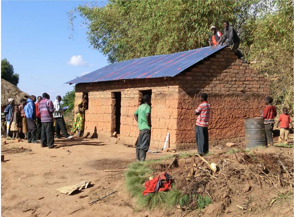
Haus mit gut erhaltenen Lehmstampfmauern, das mit sonnetrockneten Lehmziegeln aufgestockt und mit Wellblech eingedeckt wurde. Li im Bild – das Komitee besichtigt den Baufortschritt und registriert die Notwendigkeit von Türen und Fenstern. Re im Bild Handwerker bei Dachdeckerarbeiten.
