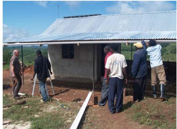
Dachrinne für VTC – Ibwanzi. Das Dachwasser wird in einem Polytank gesammelt, und für den Bau verwendet.
