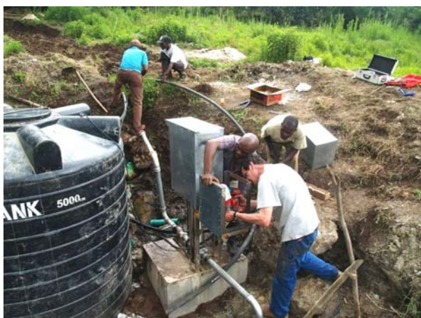
Elektrische Pumpe an der Quelfassung VTC Ibwanzi
