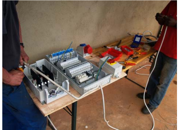
Für die elektrischen Installationsarbeiten beim VTC Ibwanzi wird der Schaltkasten in der Werkstätte Mdabulo vorbereitet.
