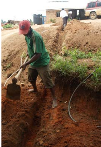
Elektrische Leitungskabel werden vom Power House zum VTC Gebäude verlegt
