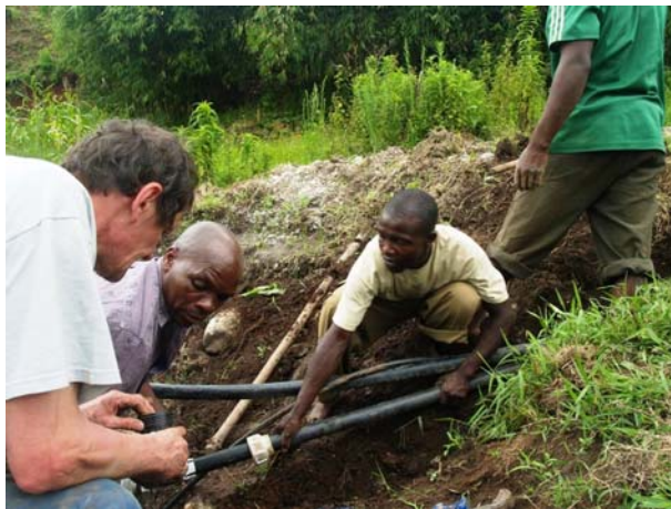
Leitungsrohre werden zusammengefügt
