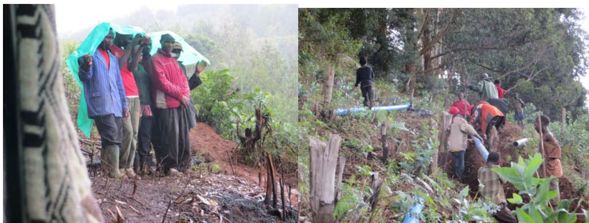
Abb. Neben unwegsamem Gelände machte den Leitungsbauern auch der anhaltende Regen zu schaffen
