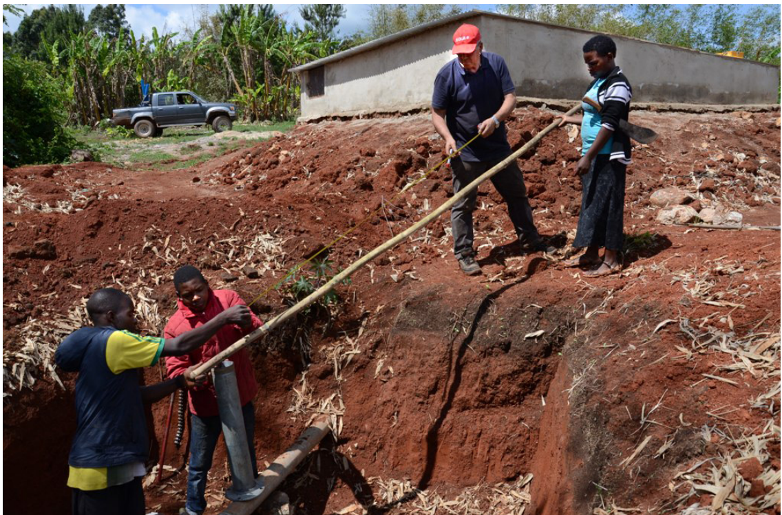
Abb. Im Hintergrund – der fertig betonierter Behälter mit Wellblech -Dacheindeckung
