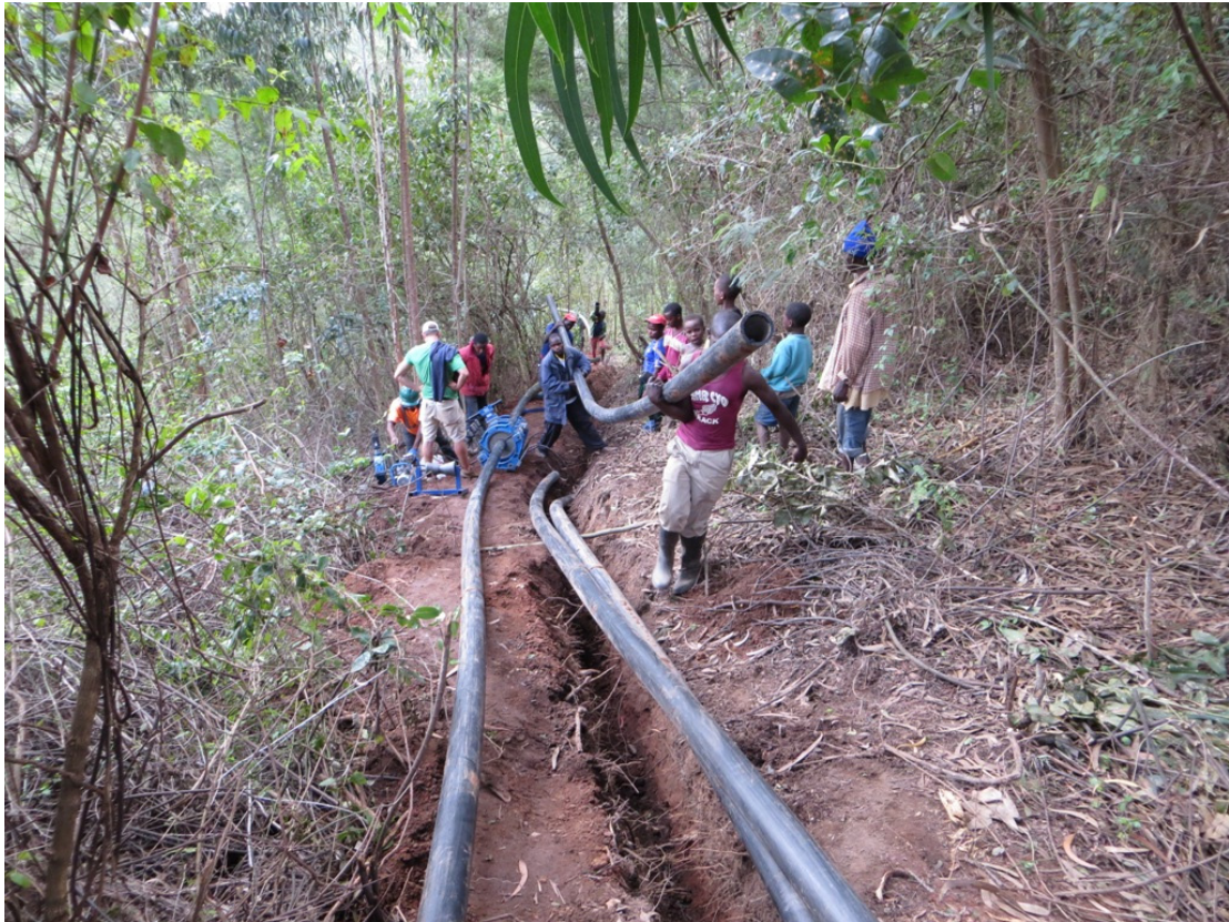
Abb. Rohrverlegung im Gelände – Bild unten: in der Talsenke müssen die stärkeren Rohre verschweißt werden
