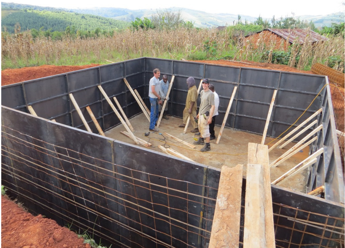
Abb. Zum Bau aller Wasserbehälter wurde in der RDO – Schlosser - Werkstätte eine wiederverwendbare Stahlverschalung gefertigt.
