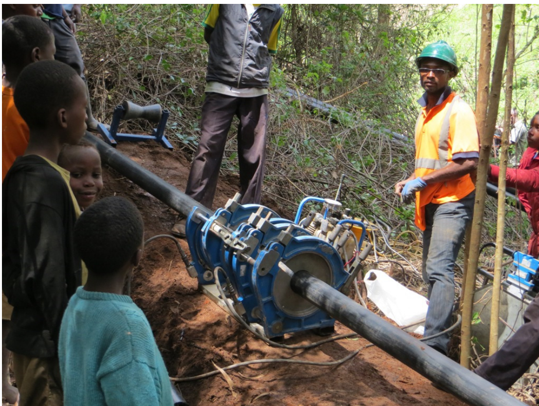
Abb. Zum Rohrverschweißen musste ein Spezialist aus Dar es Salaam angefordert werden.
