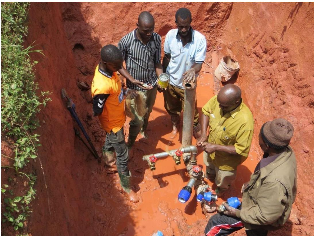
Abb. Mit Hanf werden die Rohre abgedichtet.
