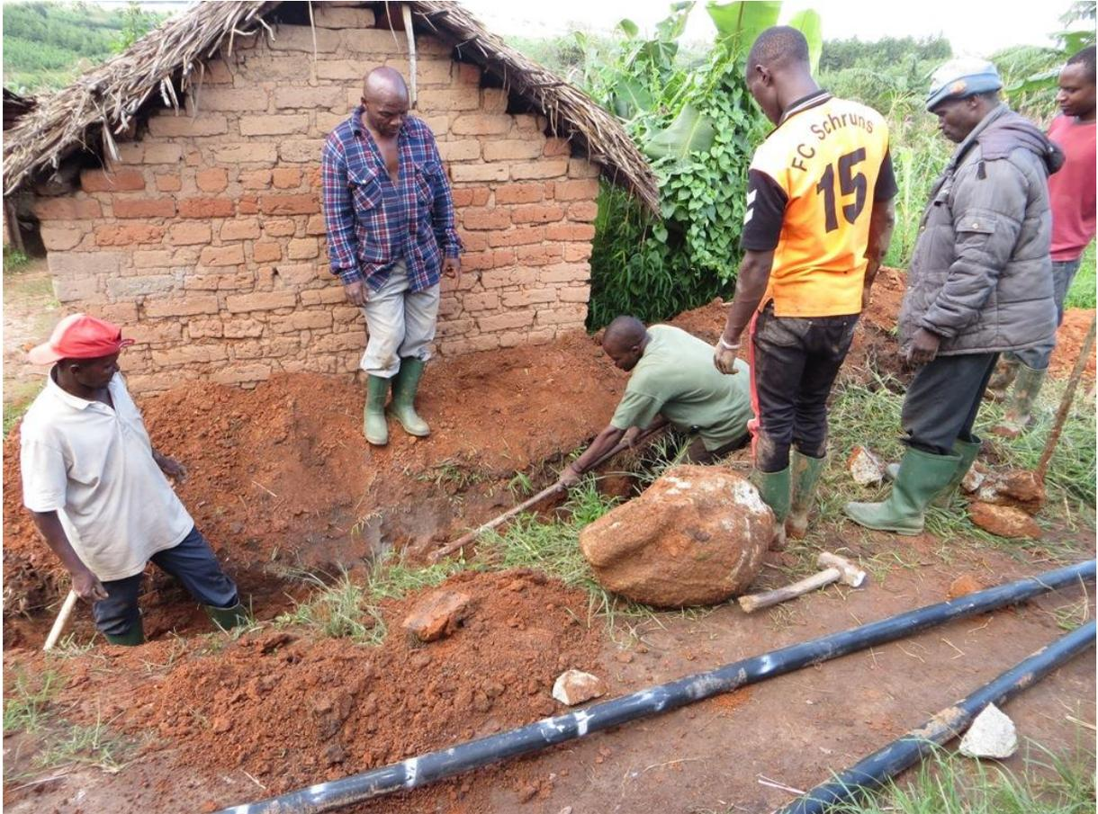
Abb. Abschnittsweise waren die Grabungsarbeiten ziemlich mühsam, mit einfachen Werkzeugen mussten große Steine mit einem Gewicht von über 200kg zertrümmert werden um den Weg frei zu machen.
