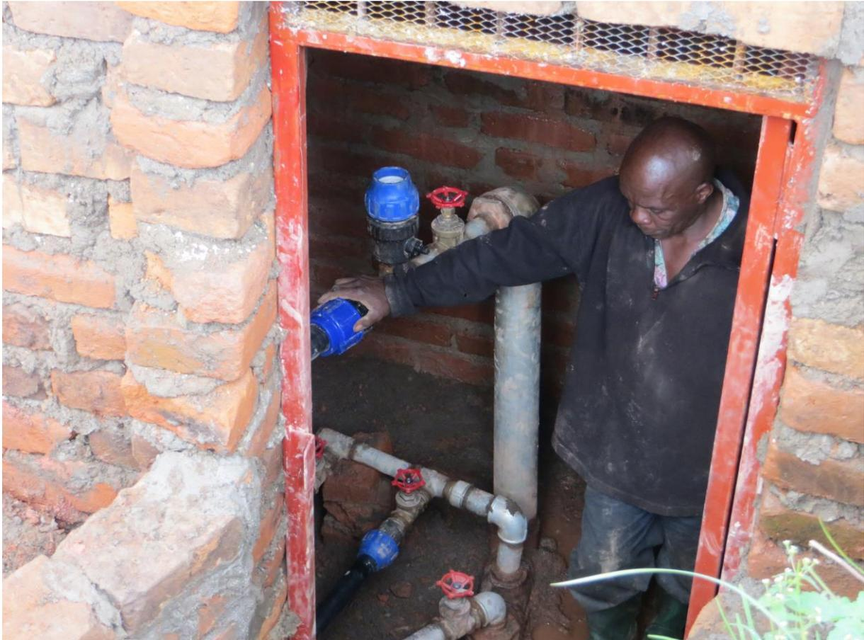
Abb. Verteiler und Absperrventile in der Brunnenstube Kidete-Markt
