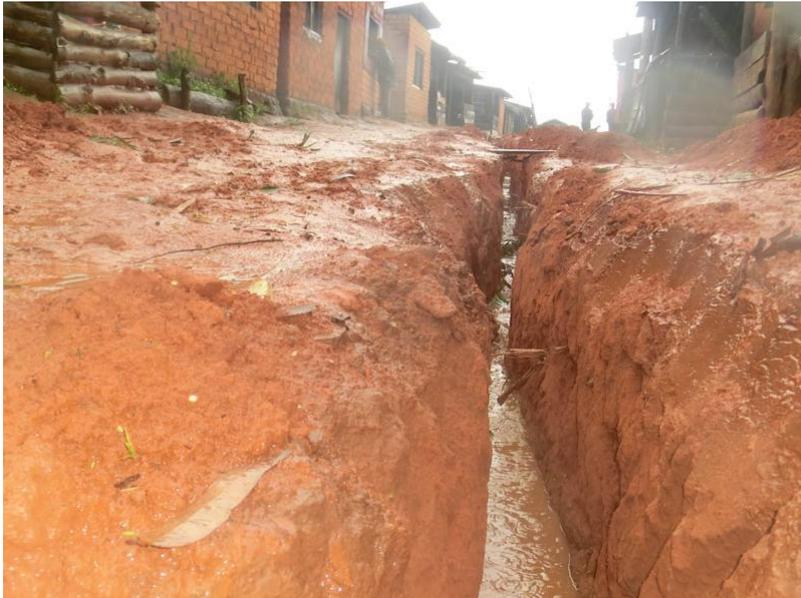
Die Hauptleitung und die Versorgungsleitung nach Ikanga wurden parallel in einem Graben geführt. Von der Versorgungsleitung Kidete führen Stichleitungen in die einzelnen Wasserstellen. Im Mittelteil des Dorfes musste die Hauptstraße durchquert werden. Diese Querung erfolgte in einer Tiefe von 2 Metern und gestaltete sich ohne Schwierigkeiten. Andere Querungen der Hauptstraße betrafen die Stichleitungen zu den einzelnen Wasserstellen. Auch diese wurden in der Tiefe von 2 Metern ausgeführt.
