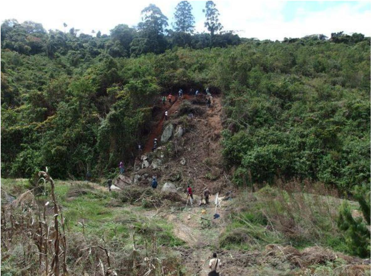
Abb. Quellfassung Ortsteil Mkuta - 130 Höhenmeter unterhalb vom Dorf. Das steile unwegsame Gelände erfordert hohen Arbeitseinsatz der Bevölkerung.
