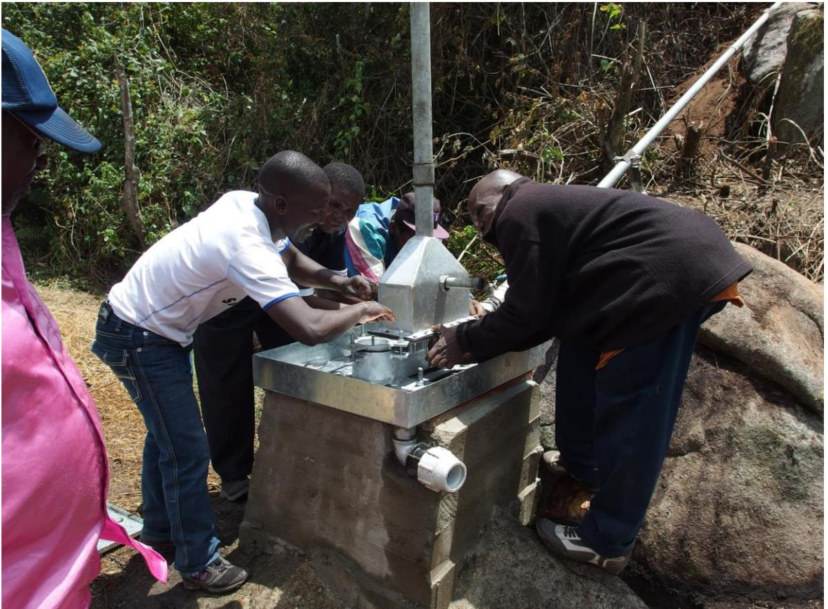
Abb. Der Widder wird befestigt.
