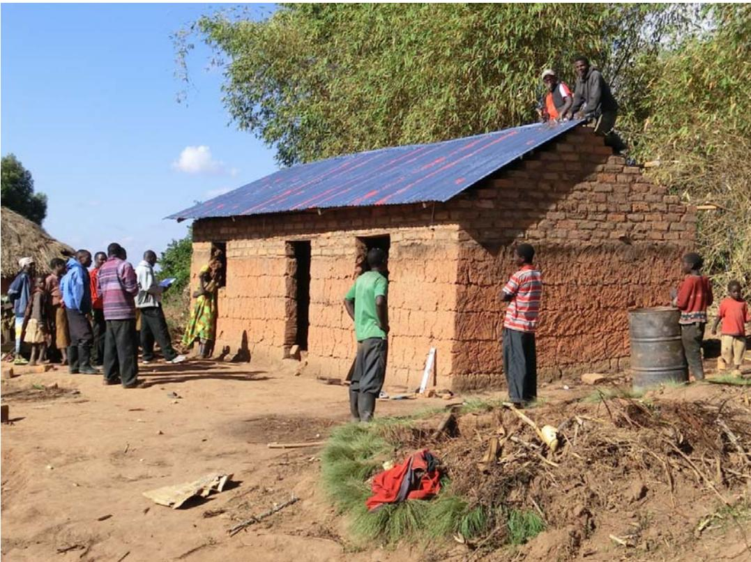
Haus mit gut erhaltenen Lehmstampfmauern, das mit sonnengetrockneten Lehmziegeln aufgestockt und mit Wellblech eingedeckt wurde. Li im Bild – das Komitee besichtigt den Baufortschritt und registriert die Notwendigkeit von Türen und Fenstern. Re im Bild Handwerker bei Dachdeckerarbeiten.
